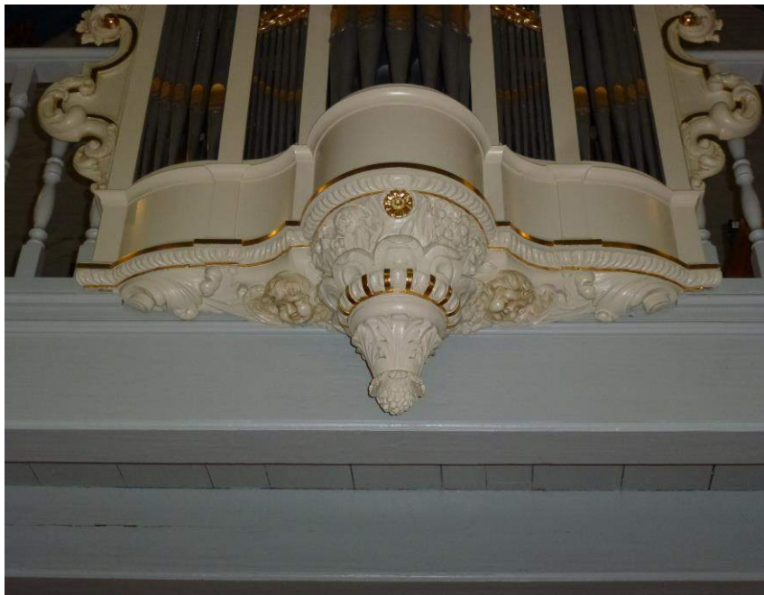
De soffiet en daarboven de basementlijst
